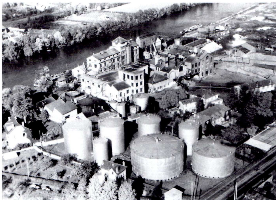
Les citernes de stockage de la mélasse et de l'alcool et les silos à sucre. (Période 1950-1960).
