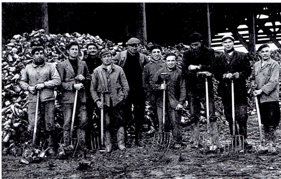
Photo extraite de l'ouvrage Roissy-en-France 1900-2000.
